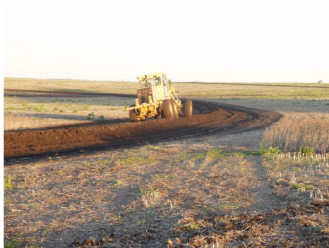
Fig.3. Terraza en construcción en el mismo predio anterior (Cololó, Soriano), con la motoniveladora conformando por atrás de la terraza de canal y tentando compactar el lomo del canal. El manejo de los suelos es sustentable
